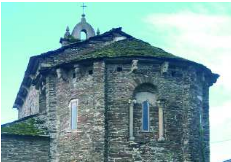
Fig. 5 Vista exterior da ábsida
